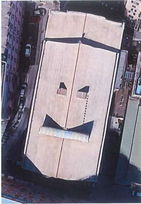
Figura 10 - Struttura oggetto di intervento (fonte Google Maps)
